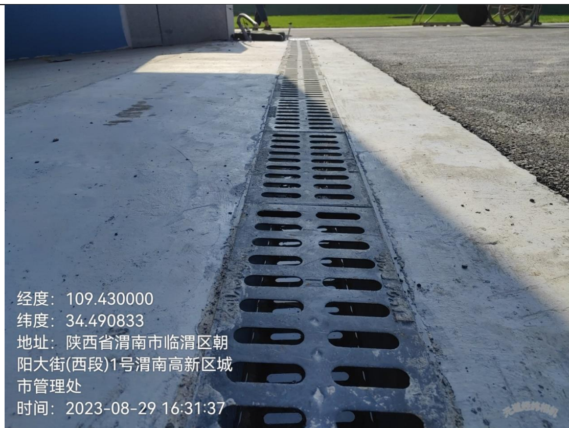
车库出入口排水沟
