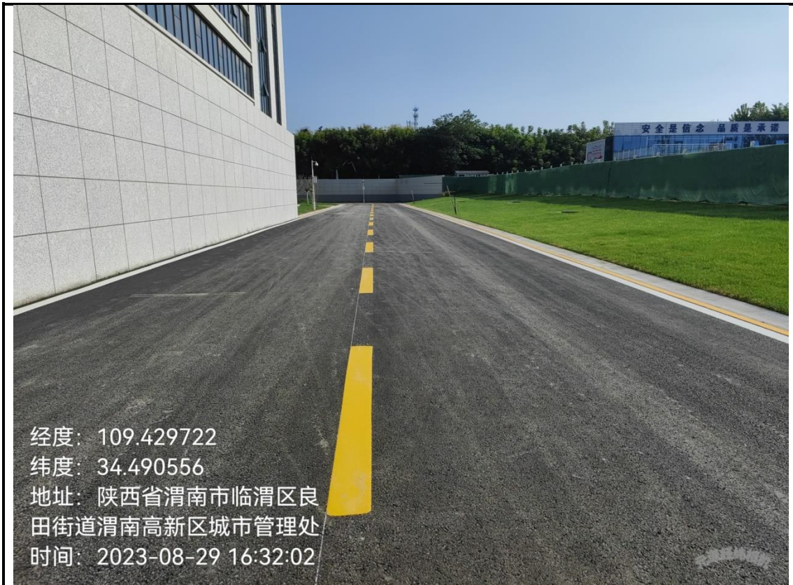
科研综合楼楼西道路
