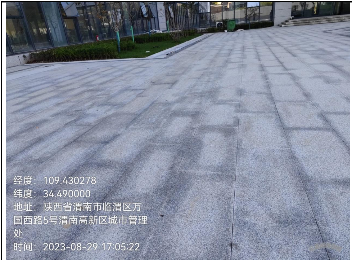
科研综合楼楼前广场铺装
